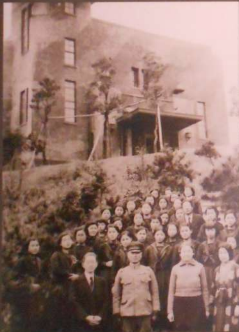
昭和12年に迷彩が施された講堂 西南女学院ロウ記念講堂(W.M.ヴォーリス設計)、現存建物 提供：学校法人西南女学院 空襲を防ぐため、この頃、大きな建物には迷彩色の防空偽装が施されました。
